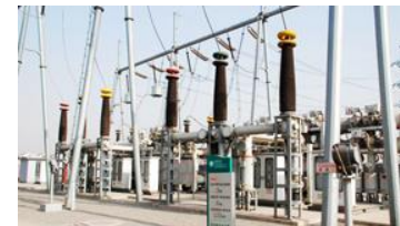
变电站无人值守监控
